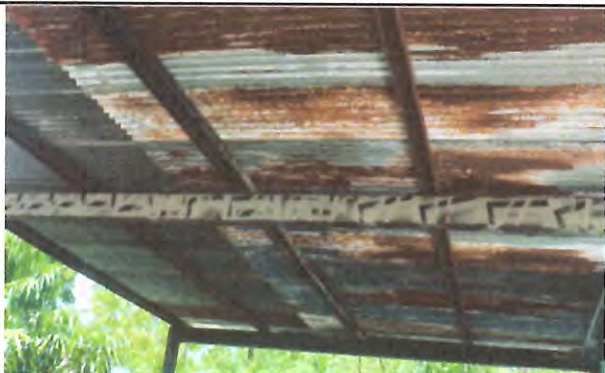
Foto 1: ESTRUCTURA DE TECHO: Sustitución de estructura metálica para soporte de cubierta de lámina, incluyendo perfiles, vigas, travesaños y anclaje de la estructura.
