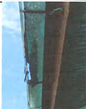
Foto 6: Sustitución de canal para evacuación de aguas pluviales.
